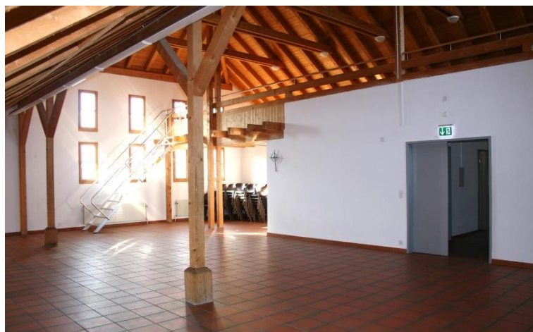
Saal mit Galerie im Dachgeschoss
